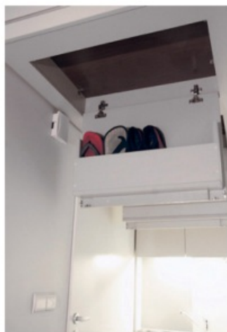
4 Úložný prostor v podhledu.
